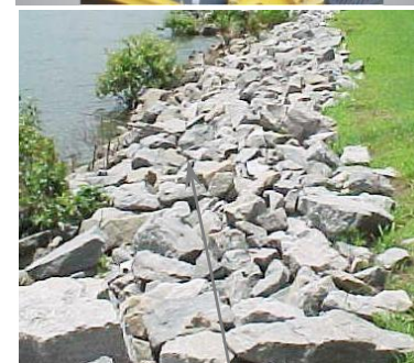
Камни для защиты береговой линии
